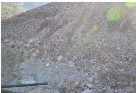
Fotografía 24: Acopio SAM 14 - Talud norte. Heterogeneidad. Erosión moderada.
