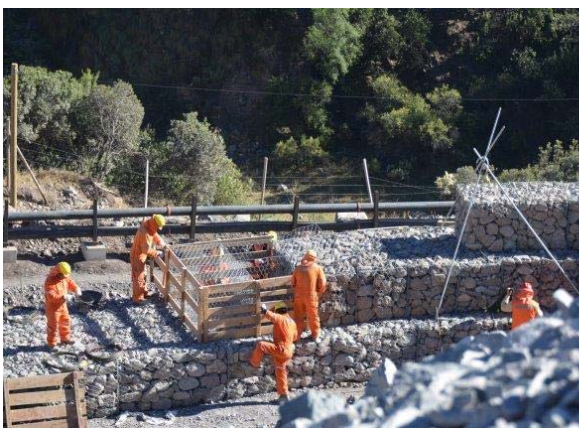
Fotografía 26: Acopio SAM 14 - Construcción de gaviones.
