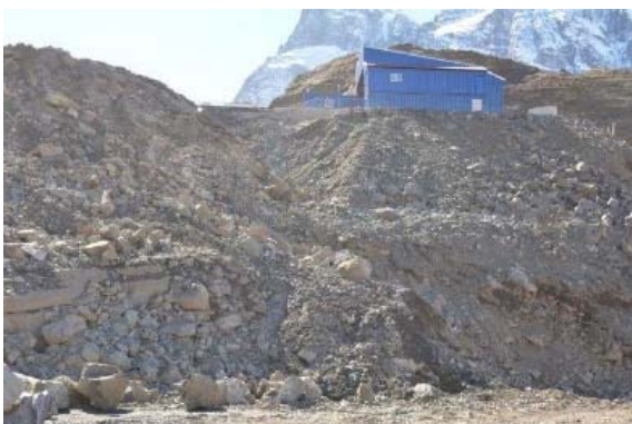
Fotografía 5: Acopio SAM 1 – Talud superior de apoyo. Corte de material.
